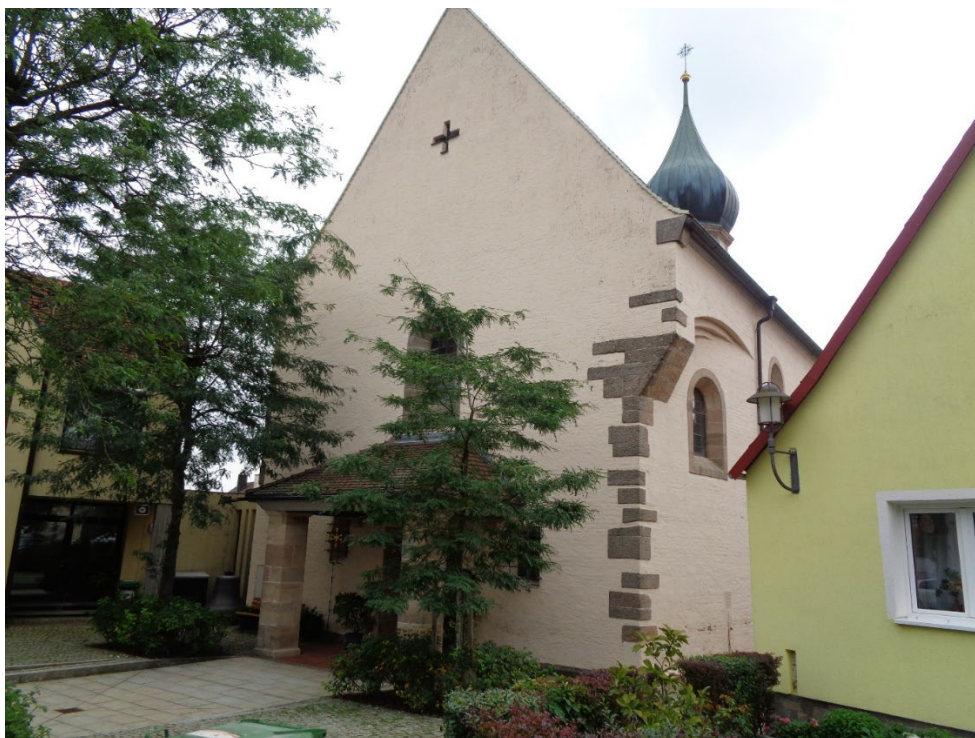
Abb. 18: Die Rückseite des Kirchenschiffs, zugänglich von Westen. Der Eingang liegt etwas versteckt
