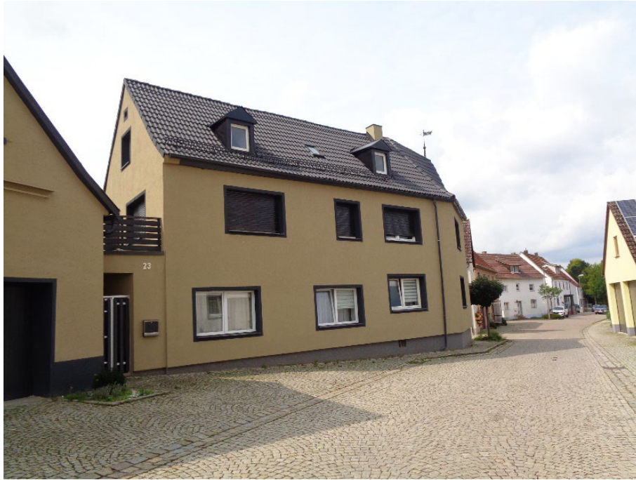
Abb. 70: Hauptgebäude der Sulzacher Str. 23
