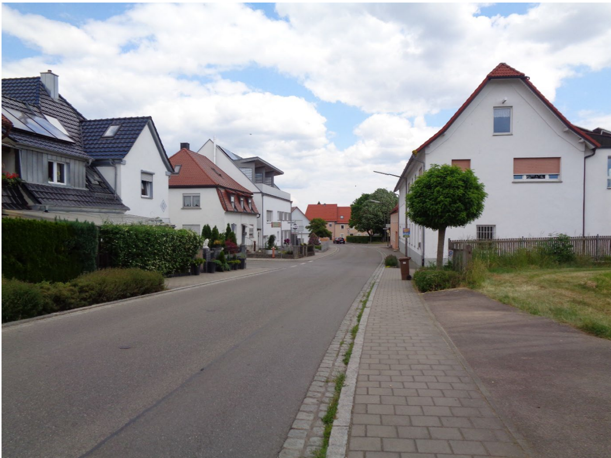
Abb. 61: Außerhalb des Ortskerns haben die Gebäude meist Satteldächer und stehen traufständig zur Straße. Nur Wenige weichen von dieser Form ab (z.B. in der Schopflocher Straße)
