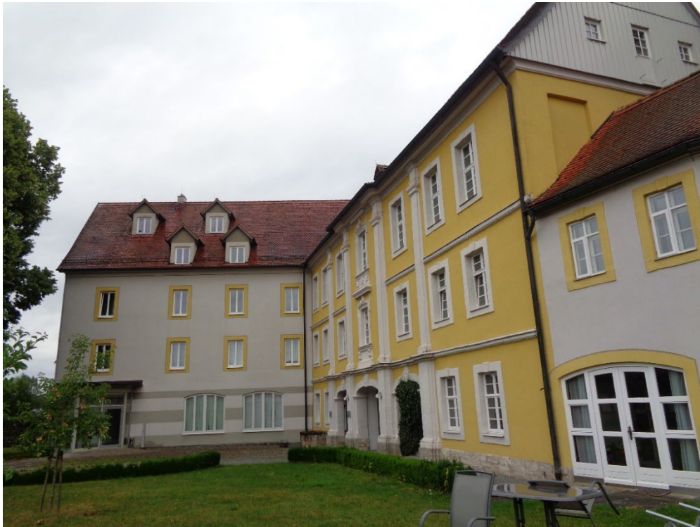
Abb. 14: Historisches Schloss Dürrwangen mit neuzeitlichem Anbau (links)
