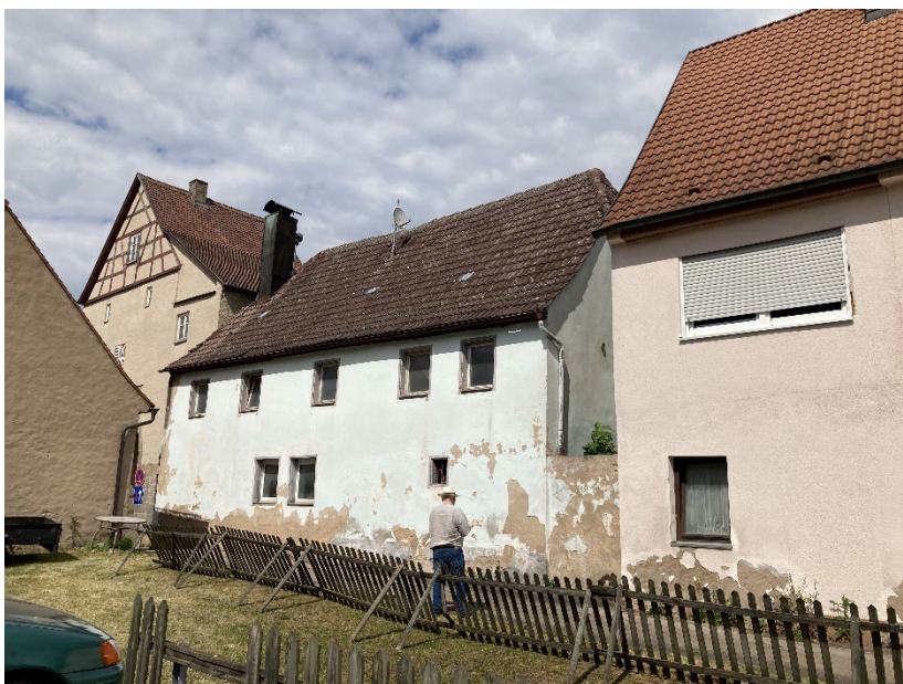
Abb. 73: Das Gebäude am Torgraben 2 steht seit mehreren Jahren leer
