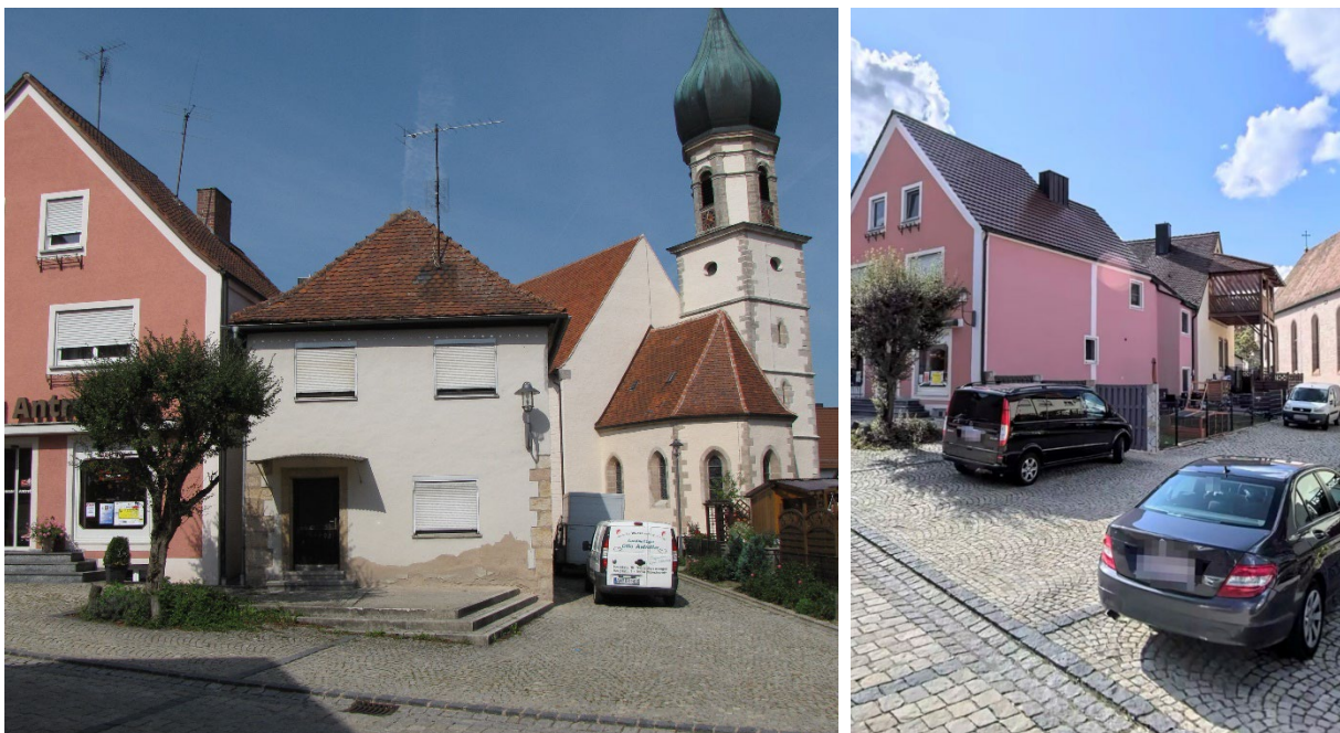
Abb. 78 und 79: Das Gebäude der Hauptstr. 8 wurde abgerissen, heute klafft an der Stelle eine Lücke
