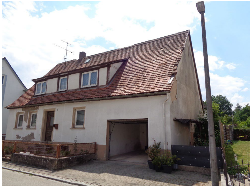
Abb. 74: Leerstand in der Turnhallenstraße, das Gebäude ist in einem schlechten Zustand
