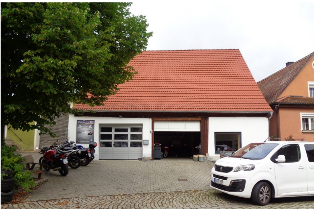
Abb. 68 und 69: Hesselbergstr. 4 und Marktplatz 9: beide stark überformt
