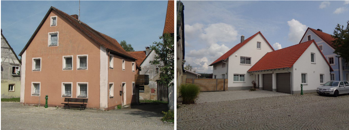
Abb. 80 und 81: Anstelle des Gebäudes in der Sulzacher Str. wurde ein zurückversetztes Gebäude mit vorgelagerter Garage errichtet. Eine räumliche Wirkung erzielt sie kaum
