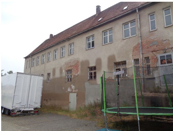
Abb. 75: Gebäude der ehemaligen Haarzurichterei in der Hauptstraße
